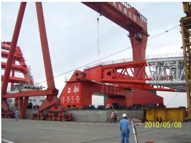
图 2 臂架根部与船体龙门架绞座的安装
