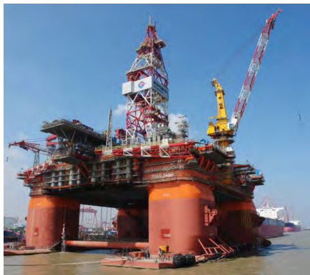
图 1 “海洋石油 981”半潜式钻井平台
